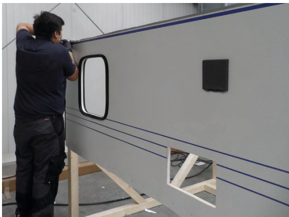
Abbildung: Instandsetzungsarbeiten an einer Sandwichplatte (Quelle: P. Lindner, Niesmann Caravanning GmbH & Co KG)
