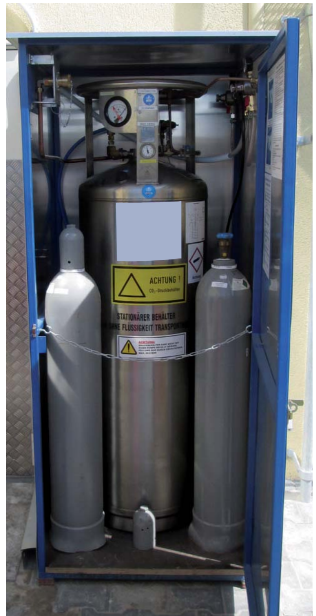
Abb.4: Stationäre CO 2 Versorgung mit Airseparator und Gasmischer
