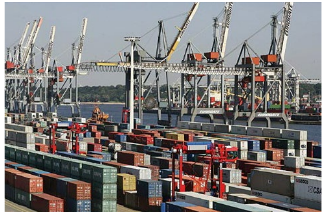
Abbildung 3: Containerumschlag im Seehafen mit Portalkränen für den Im- und Export (Quelle: BFW Hamburg)
