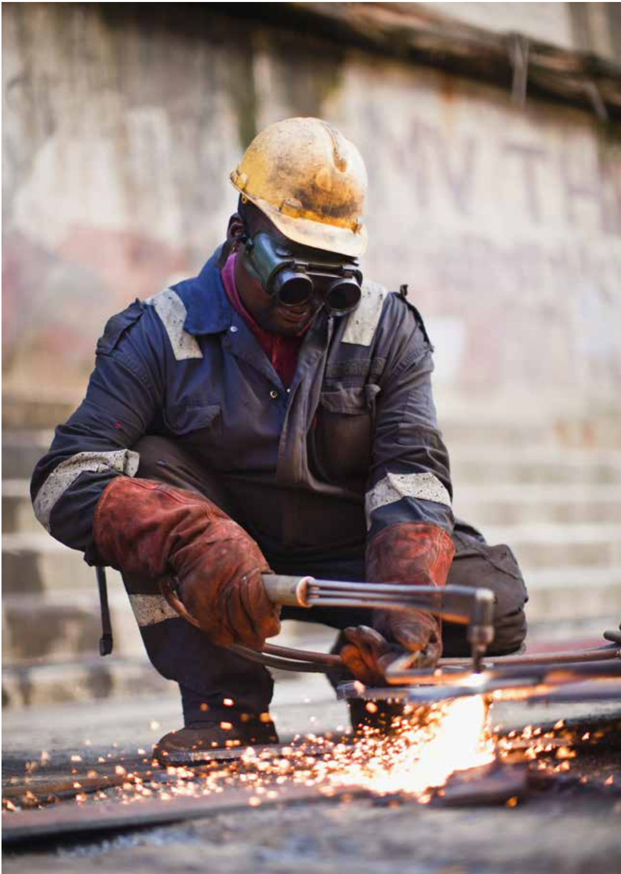
Schweißarbeiten auf einer Baustelle
