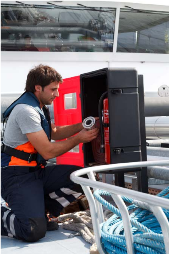
Abbildung 5: Kontrollieren einer Löscheinrichtung (Quelle: BDB, Platina-Projekt)
