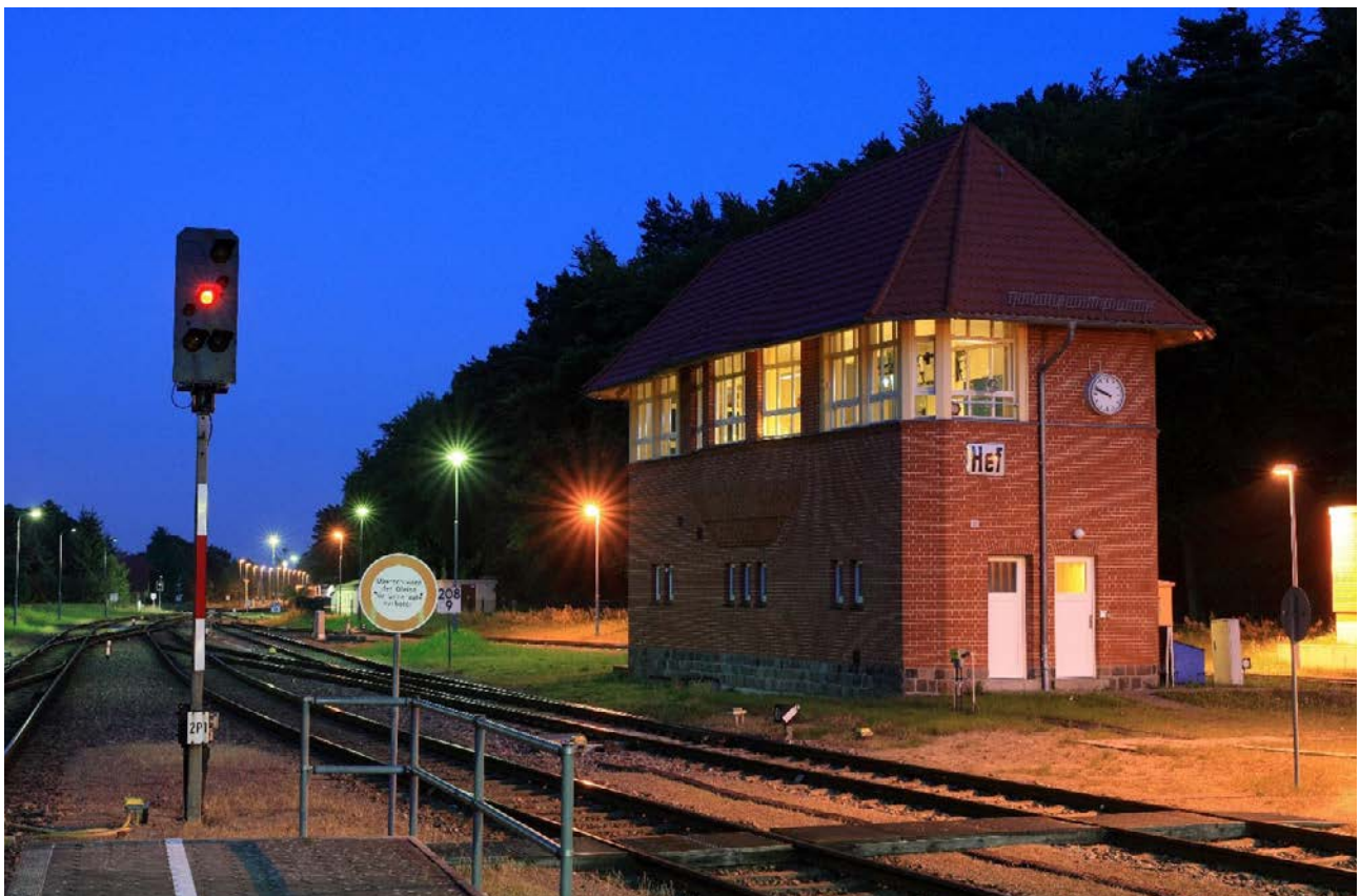
Abbildung 7: Fahrdienstleiterstellwerk Hef an der Ausfahrt des Bahnhofes Ostseebad Heringsdorf auf der Insel Usedom. Links ein Hp 0" zeigendes HI-Licht-Hauptsignal (Quelle: Deutsche Bahn AG/Uwe Miethe)
