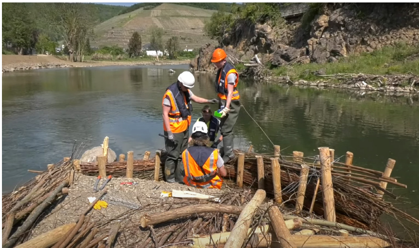
Nachhaltiger Wiederaufbau der Ufersicherung im Ahrtal im Rahmen eines Azubiprojekts Screenshot: Wasserstraßen- und Schifffahrtsverwaltung des Bundes
