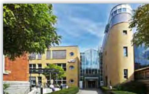
Elektro-Technologie Zentrum Stuttgart
