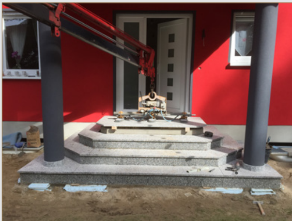
Abb. 10: Eingangstreppe mit hergestellten Werksteinstufen auf vorhandenen Betonkern versetzen @Teich
