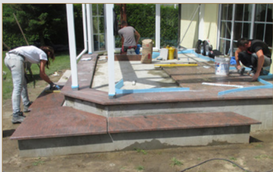
Abb. 7: Terrasse mit Treppenstufen und Bodenplatten mit hochwertigen hergestellten Werksteinen verlegen und versetzen @ Teich
