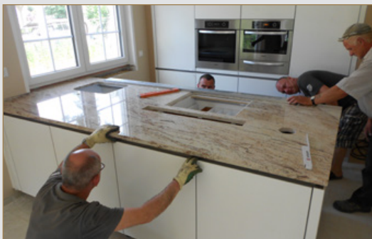
Abb. 8: Exklusive Küchenarbeitsplatte aus Werkstein montieren @ Teich
