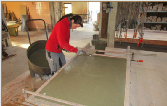
Abb. 9: Betonieren eines Werksteinelements © Teich
