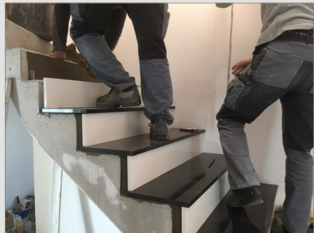
Abb. 11: Tritt- und Setzstufen auf gewendelten Betonfertigteillauf versetzen @ Teich
