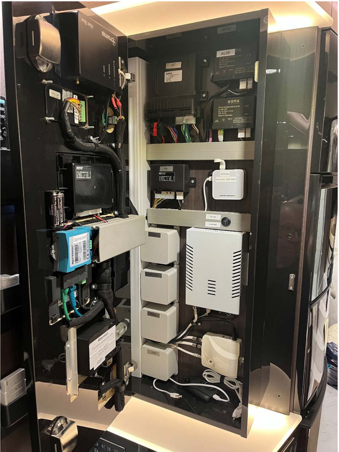
Abbildung 26: „Schaltzentrale“ eines Reisemobils (Quelle: ZKF)
