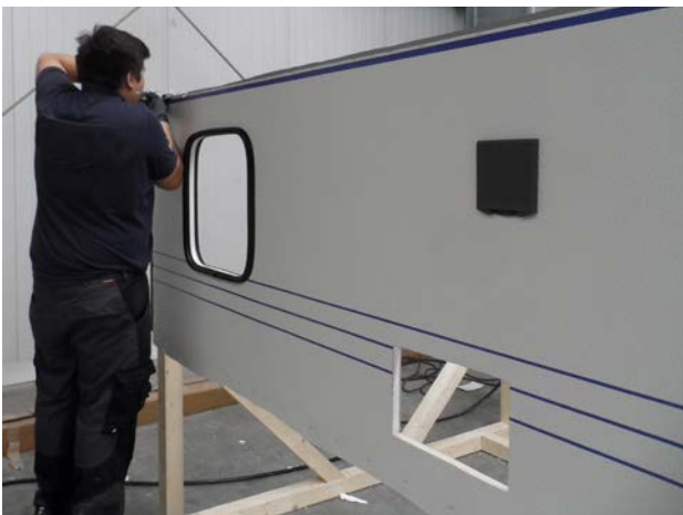
Abbildung 40: Instandsetzungsarbeiten an einer Sandwichplatte (Quelle: P. Lindner, Niesmann Caravaning GmbH & Co. KG)
