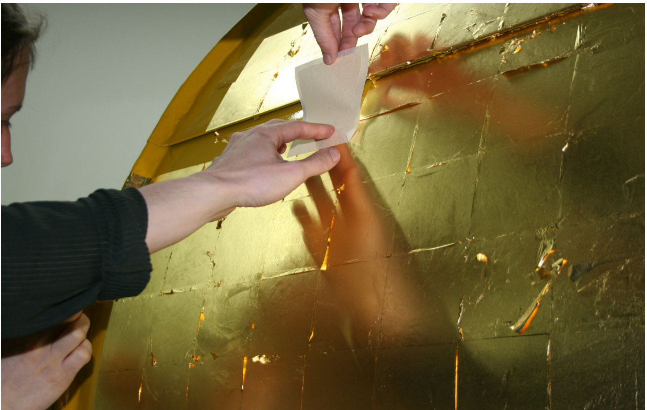
Abbildung 11: Vergolden einer Turmhaube mit Transfergold (Quelle: Städtische Fachschule für Farb- und Lacktechnik München)
