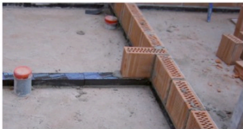
Placement d'un élément isolant (ici : verre cellulaire) sous le premier bloc pour éliminer le pont thermique
