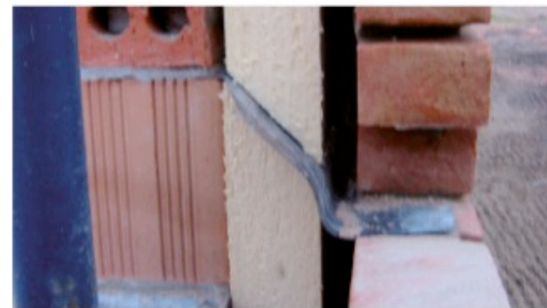
Mise en oeuvre du parement après placement soigné de l'isolation
