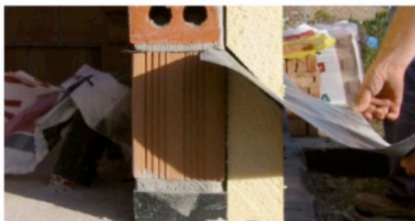
Placement de l'isolation en pied de mur
