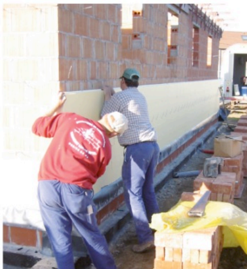
Placement des panneaux isolants contre les blocs : bon contact contre le mur + fermeture et alternance des joints. La pose des panneaux doit se faire en totale indépendance de la mise en oeuvre du parement afin de garantir la continuité de l'isolation.
