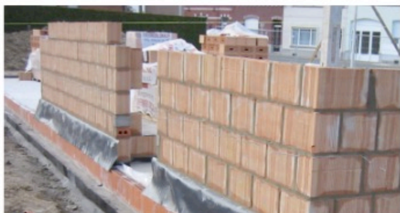
Élévation des blocs intérieurs avec pose des membranes d'étanchéité
