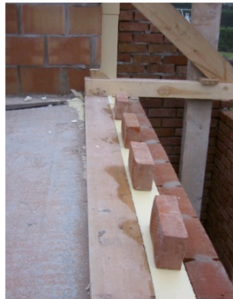
Continuité de l'isolation du mur jusqu'en charpente
