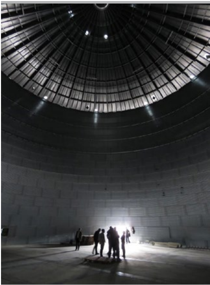
Abbildung 14: Im neuen Silo nach Abschluss der Bauarbeiten (Agrifutura GmbH; M. Bretschneider)
